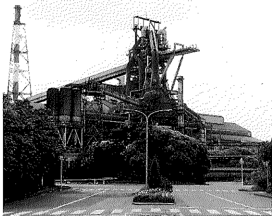
溶鉱炉では鉄の原料「銑鉄」が取り出される
